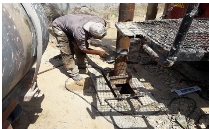
لوله‌گذاری چاه مشاهده‌ای پس از عملیات حفاری
